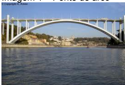
Imagem 1 – Ponte de arco
